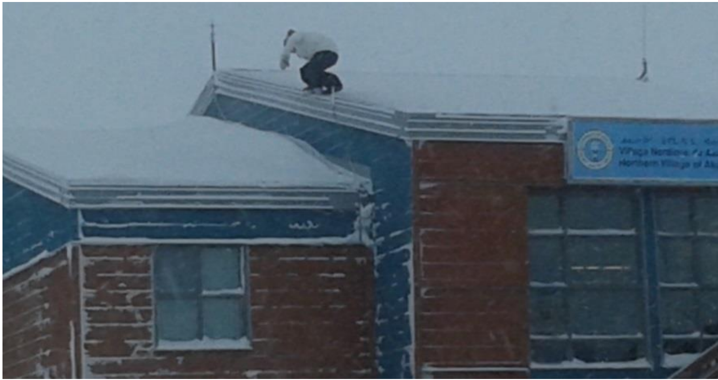
Un employé installe l'éclairage des Fêtes.
